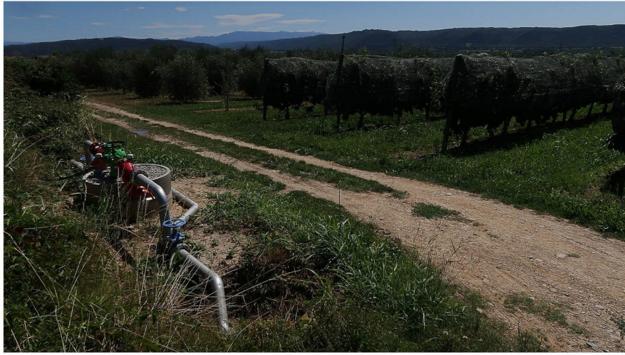
Le canal basse pression n'est visible qu'à l'endroit précis de la desserte de la parcelle. (Canal de Manosque, 05/08/2021)
