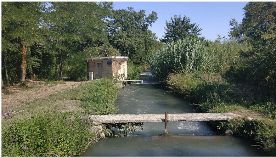
Une ancienne traversée de la Filiole de Montfavet et le local technique gérant les débits vers les filioles secondaires. (Canaux de la plaine d'Avignon, 20/08/2021).
